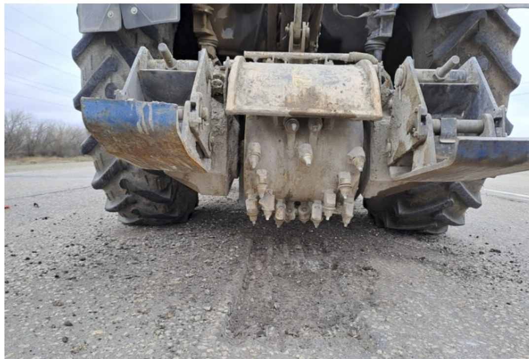
6-сурет – Өздігінен жүретін суықтай жол жонғышымен асфальтбетон жабынын кесу
