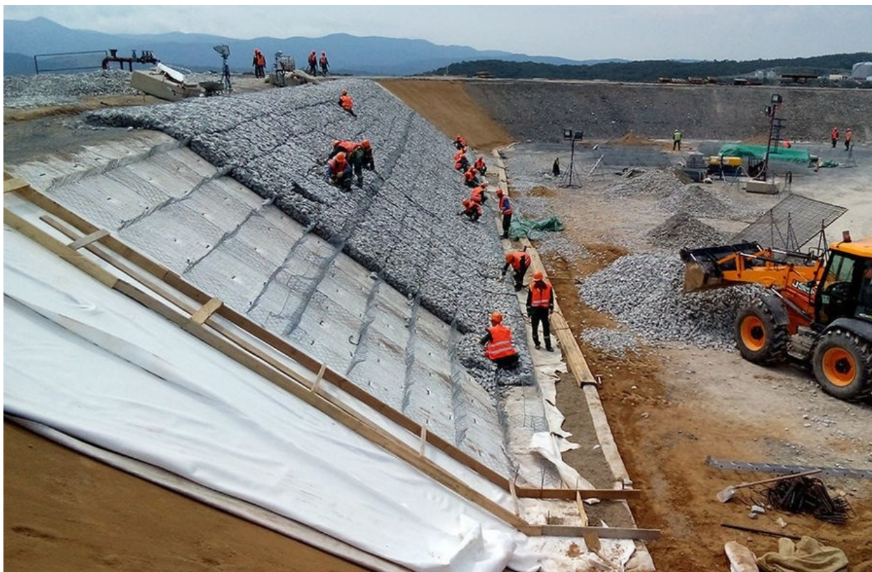
7-сурет – Матрац-төсеніш ГТБ таспен толтыру
