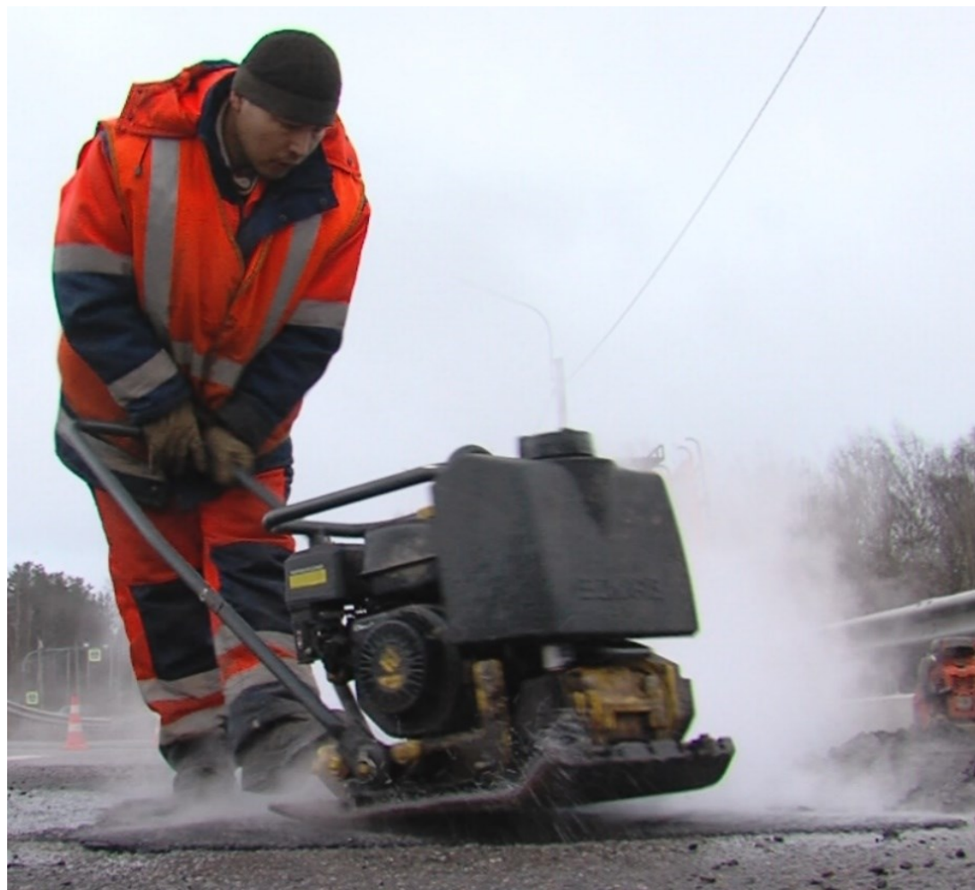
9-сурет – Жөндеу аймағында регенерацияланған асфальтбетон қоспасын төсеу және тығыздау
