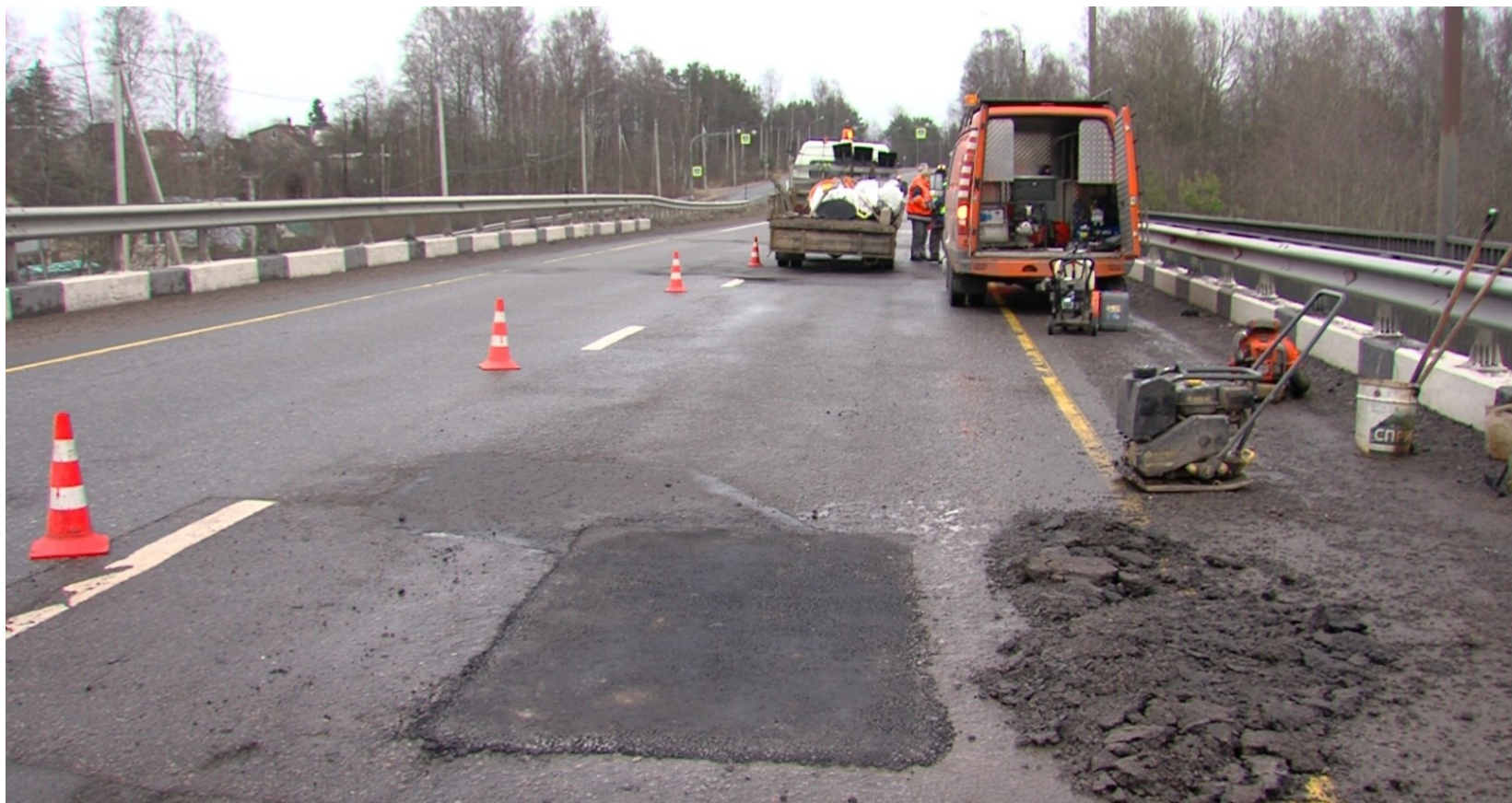
10-сурет – Жөндеу аймағында төселген регенерацияланған асфальтбетон қоспасы
