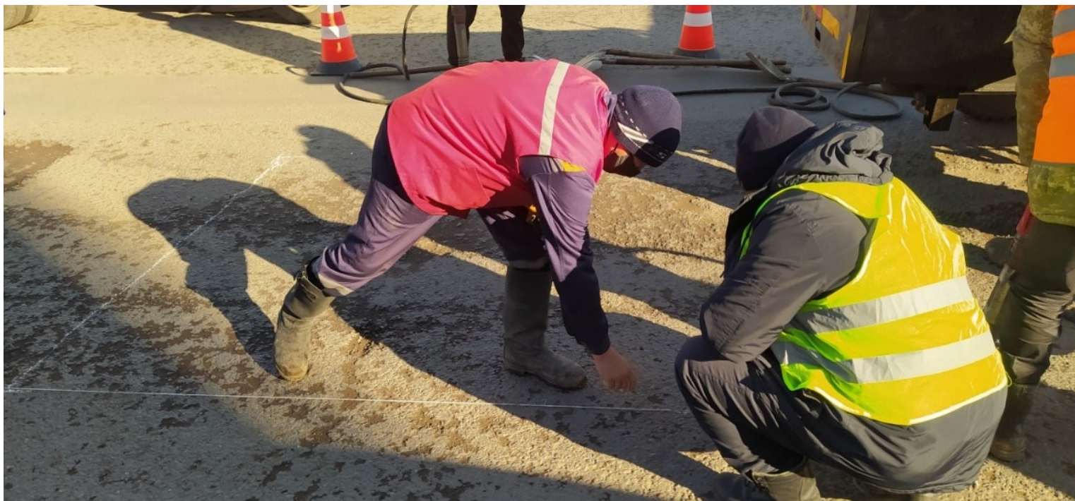
5-сурет – Асфальтбетон жабынының жөндеу шекараларын белгілеу және таңбалау
